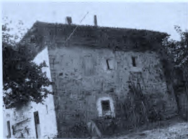
Caserío Elixa con el tejado a cuatro aguas. Foto del autor, 1975.
