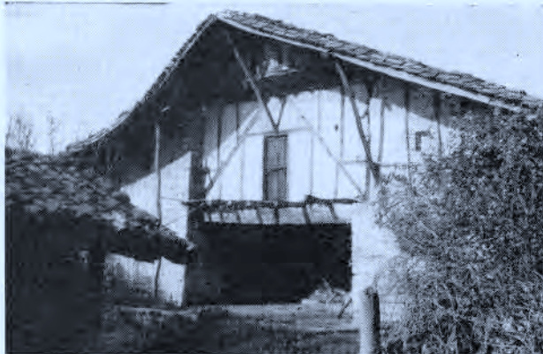
Fachada y horno del caserío Sabale-Goikoa , construído en 1632. Foto del autor, 1975.
