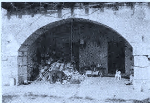
Detalle del arco del caserío antes citado. Foto del autor, 1975.
