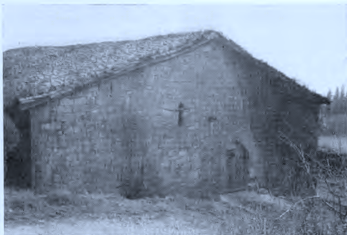
Contrafachada del caserío Zabale-bekoa . Los informantes dicen que fue construida por los moros y que era moro-etxia , casa de moros. Foto del autor, 1975.
