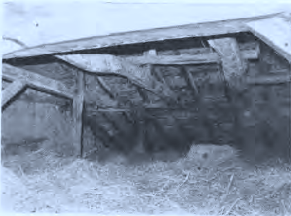
Foto — 1.18.18 — Atxutegi-bekoa. Armadura del tejado.
