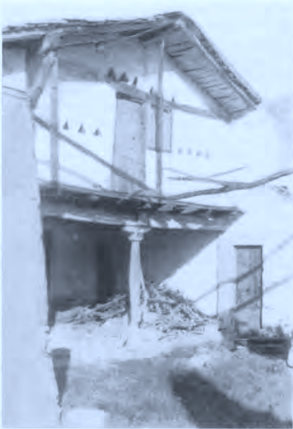
Foto — I.14.9 — Portal de Ibergune.
