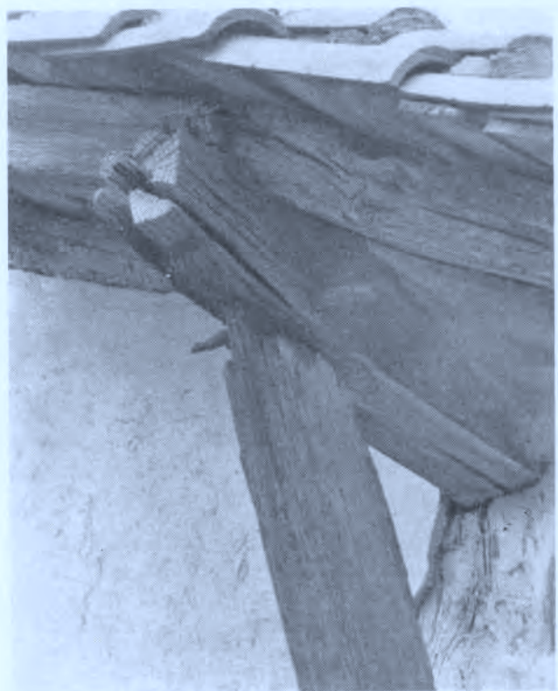
Foto — I.18.16 — Atxutegi-bekoa. Zapata trabada con un pasador de madera (Espige).
