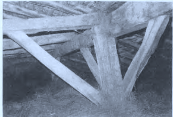
Foto — I.18.17 — Atxutegi-bekoa. Apoyos de la armadura del tejado.
