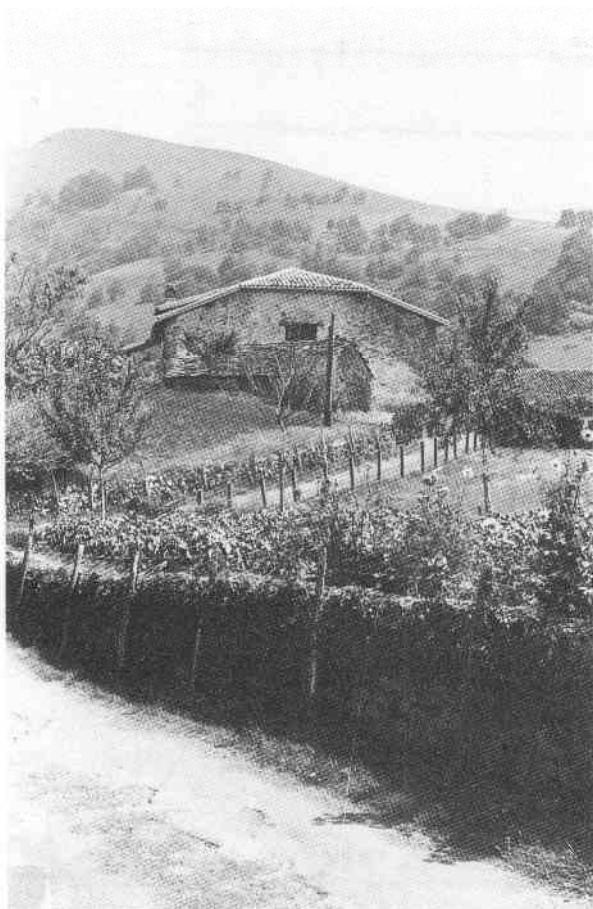
Fig. 8: Mur de propriété bordant un chemin; il est en pierres sèches et doublé par du barbelé.
