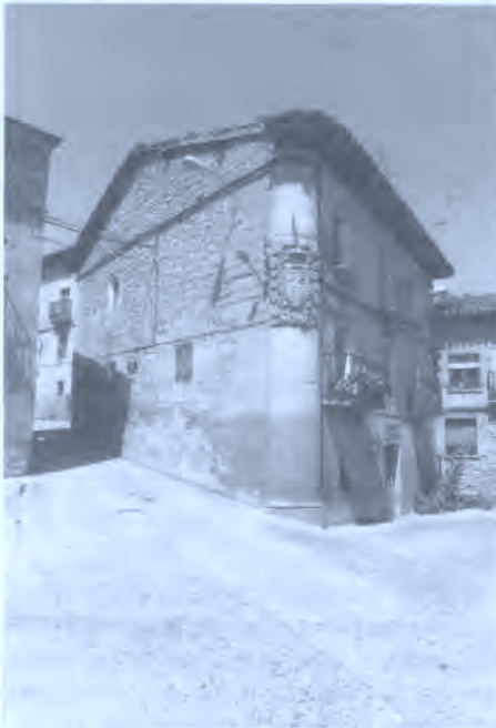
Fig. 18. Casa de los García de Jalón.
