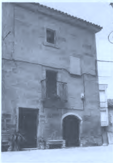
Fig. 7. Casa barroca del s. XVIII.
