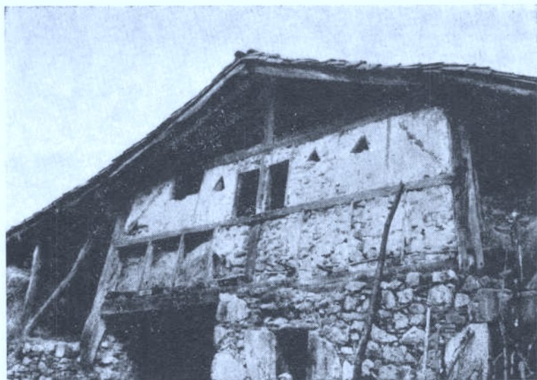
Entramado de madera del caserío-hórreo de Amantegui-Barrena.
