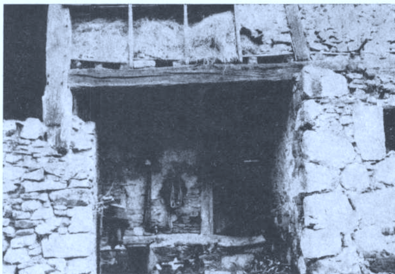
Portal adintelado del caserío-hórreo de Amantegui-Barrena.
