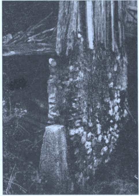
Poste B y aspecto lateral de la prolongación trasera del tejado.
